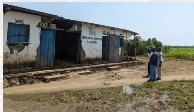
Fig. 3: Le bureau du quartier Kahororo envahi par les eaux | Crédit Photo: Altinah Rutaha
